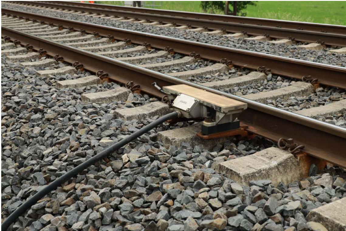
Abbildung 12 Gleismagnet der PZB bahnrechts, ca. bei OLA-Mast 151-3
