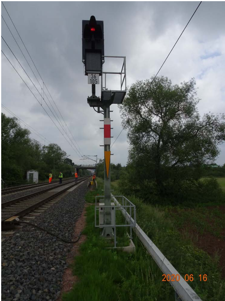
Abbildung 14 Signalmast und aufgeständerter Kabelkanal bahnrechts, Blick in Kilometrierungsrichtung
