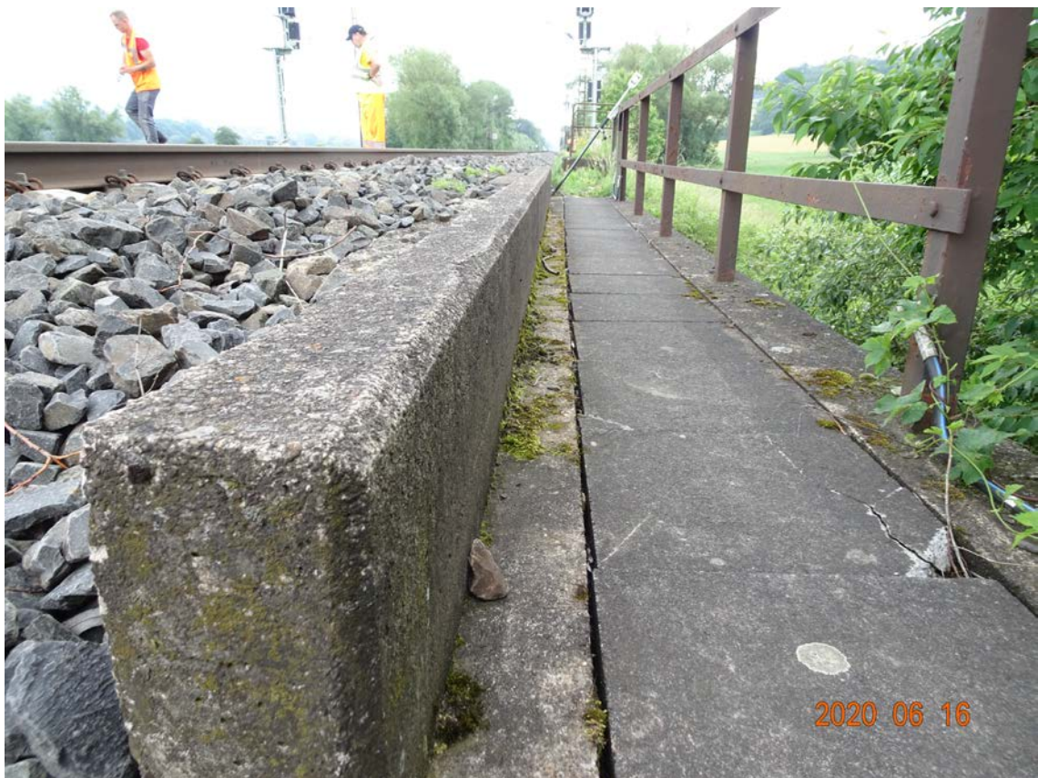
Abbildung 8 Randbalken West mit Schotterhalterung, Kabelkanal und Geländer
