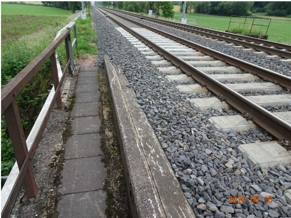
Abbildung 26 Randbalken mit Schotterhalterung, Geländer, integriertem Kabelkanal sowie Kabelkanal mit Konsolauflagerung bahnrechts
