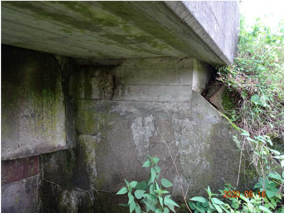
Abbildung 5 Unterseite nachträglich ergänzter Randbalken und Auflager West,
