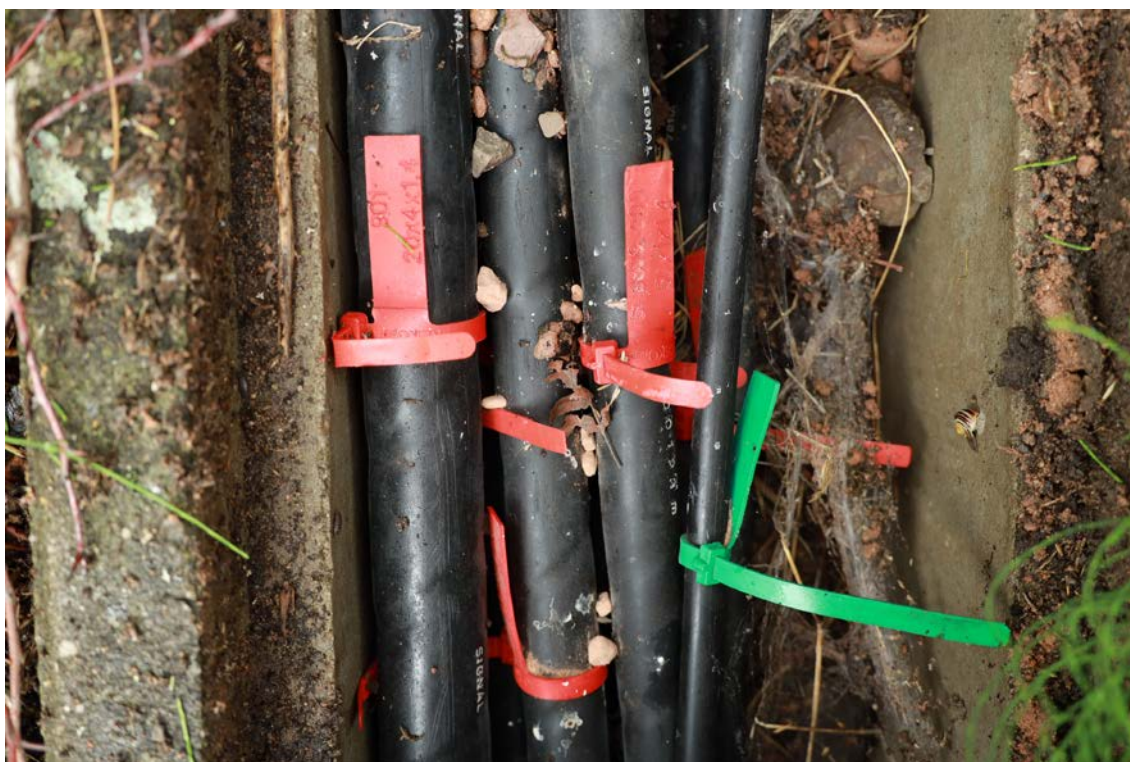
Abbildung 28 Detail Kabel im Kabelkanal bahnlinks
