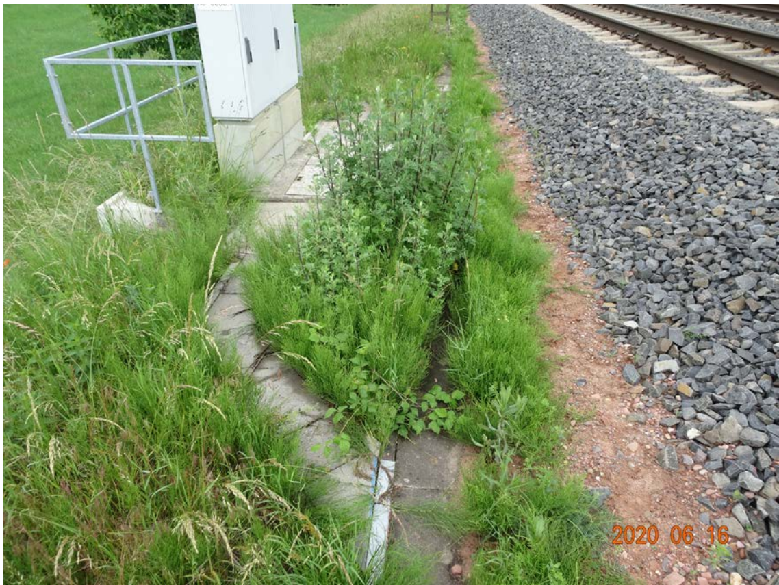
Abbildung 20 Detail Kabelkanal am Schaltschrank bahnlinks
