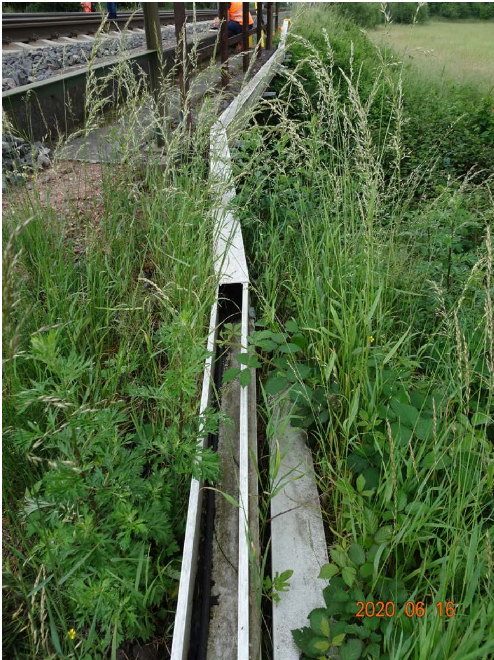
Abbildung 24 aufgeständerter Kabelkanal bahnrechts
