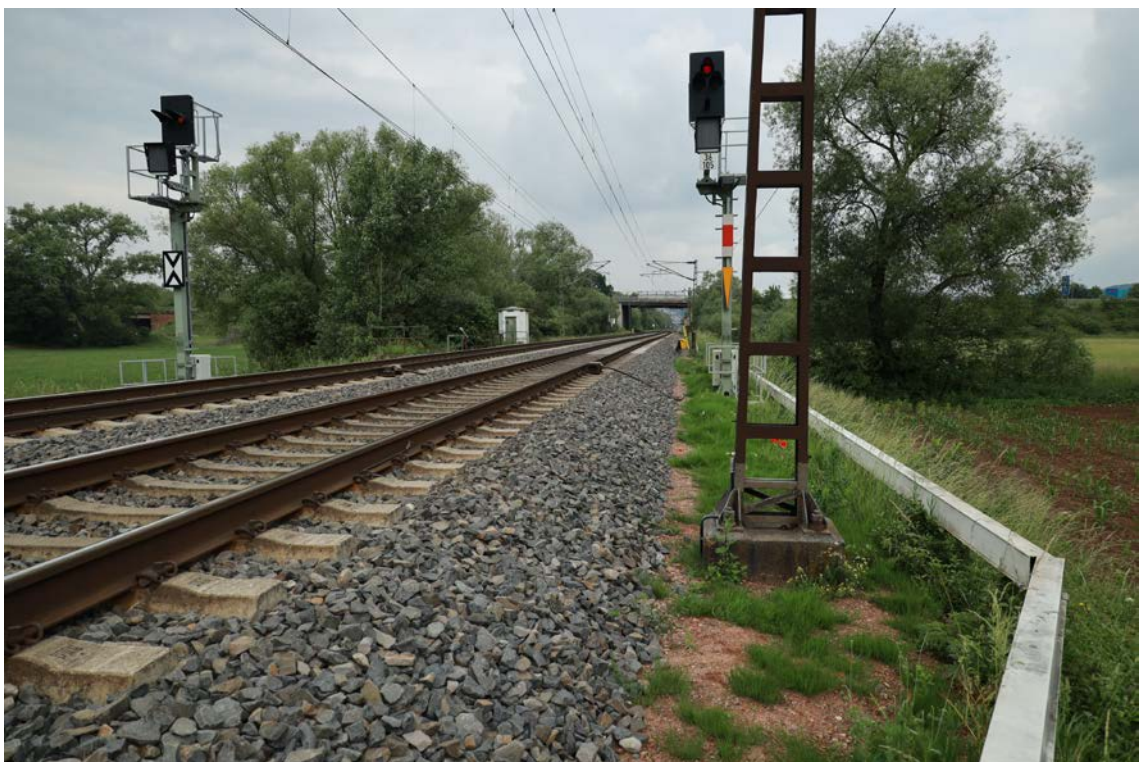
Abbildung 13 Gleismagneten der PZB, Blick entgegen Kilometrierungsrichtung
